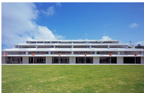
沖縄県看護研修センター 竣工年月日2013年 11月
