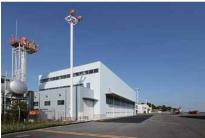
格納庫 外観南面全景
