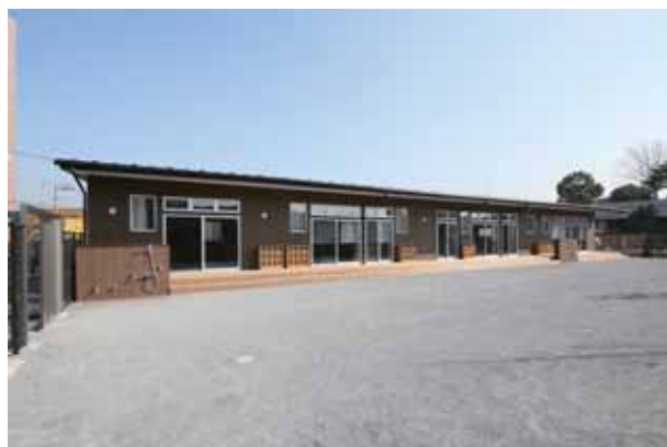
(株)ケー・アール建築研究所 鶴見区元宮二丁目方面保育園新築工事
